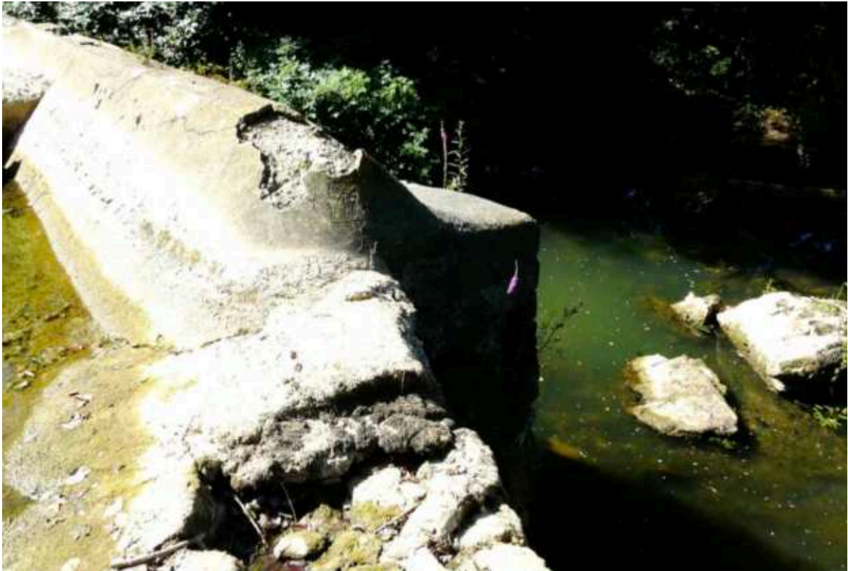
Figure 5 - Rehausse du barrage du côté rive gauche (08/2016)
