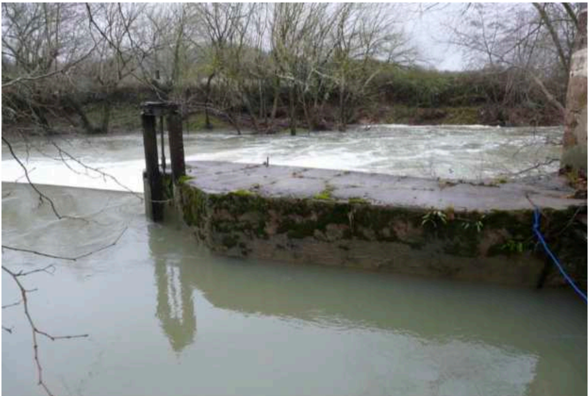
Figure 6 - Bajoyer en rive gauche du canal d'amenée (02/2017)
