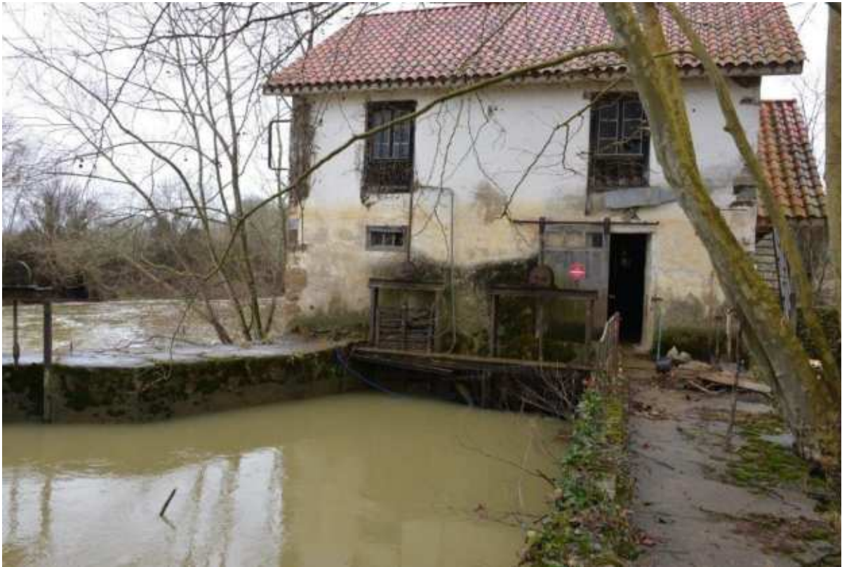
Figure 7 - Vue de canal d'amenée et du moulin depuis l'amont (06/07/2017)
