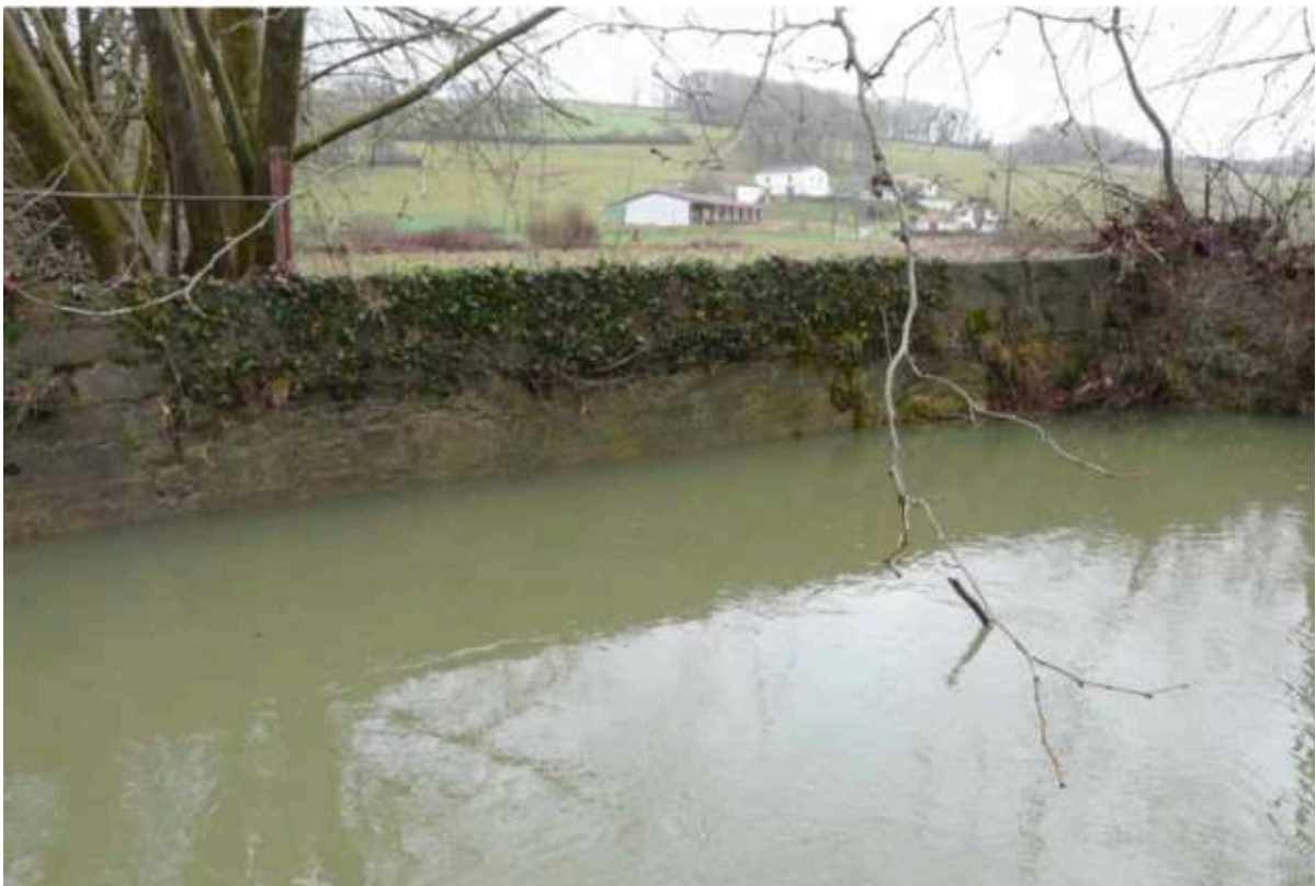
Figure 8 - Vue du bajoyer en rive gauche du canal d'amenée (02/2017)
