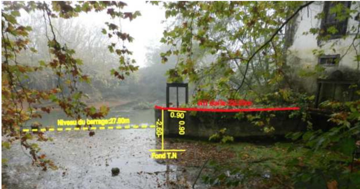
Figure 2 : Photos prises lors des mesures de Geobigorre le 18/11/16 à l'étiage.
