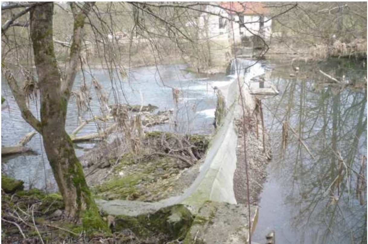
Figure 16 - Vue sur le barrage depuis la rive gauche (futur emplacement centrale et passe à poissons)
