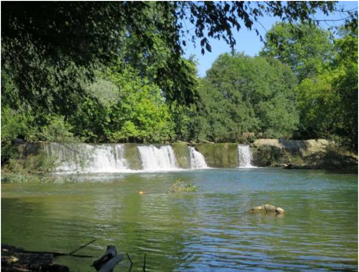
Figure 4 - Vue du barrage depuis l'aval (26/06/2018)
