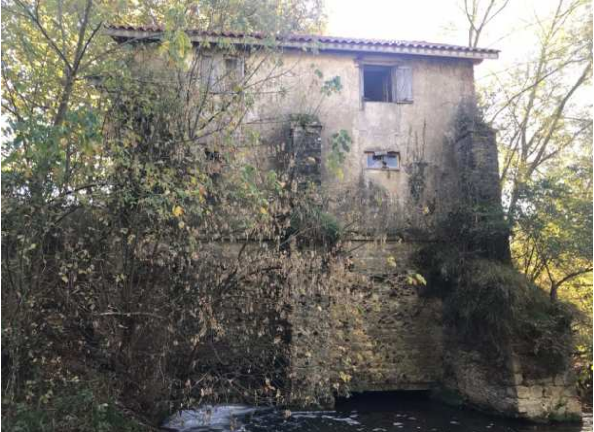
Figure 9 - Vue du moulin et de la sortie des chambres d'eau depuis l'aval (13/11/2017)
