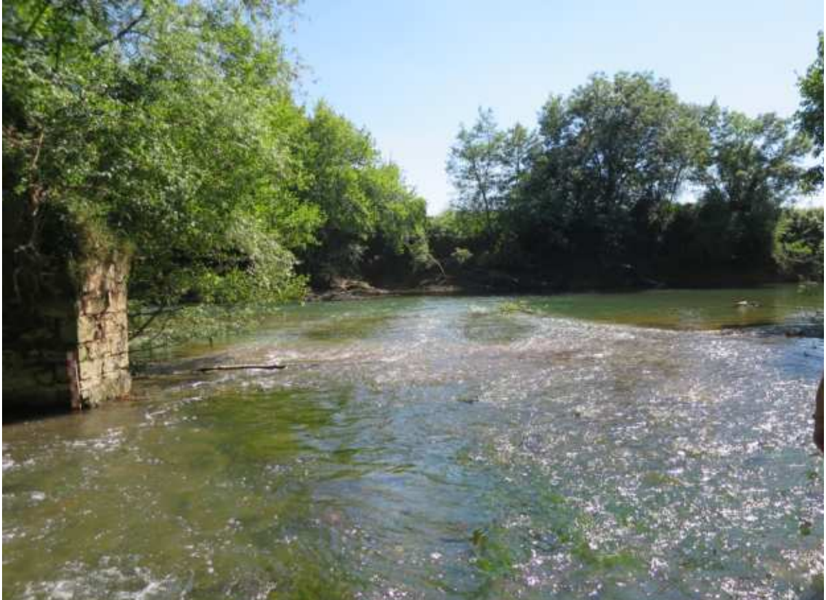
Figure 11 - Vue de la confluence entre le canal de sortie et la rivière, depuis la rive gauche (26/06/2018)
