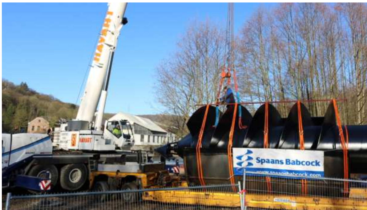
Figure 18 : Installation de la Vis hydrodynamique – Méry, Belgique - Chute : 2 m débit : 7,5 m 3 /s
