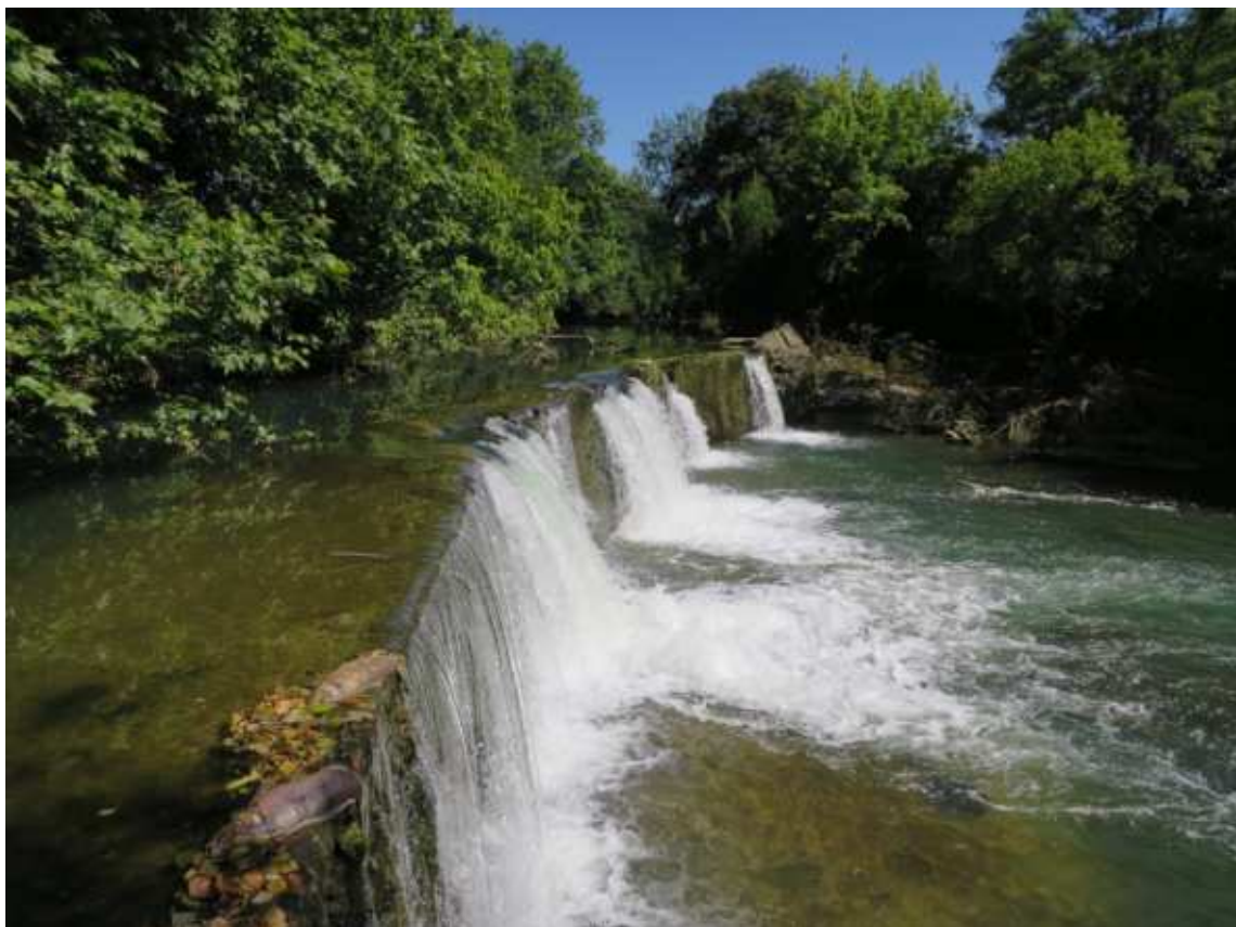
Figure 2 - Vue du barrage depuis le moulin, en rive droite (26/06/2018)
